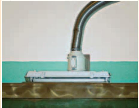
Вентилятор канальный установленный на шкаф и алюминиевый гибкий воздуховод
